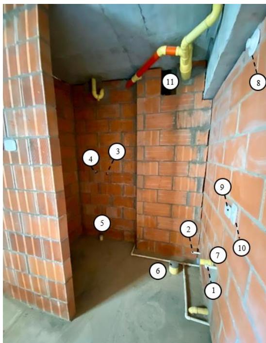
Espacio baño futuro habitación principal
